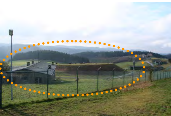
Bild 11: Beispiel einer Aufschüttung
