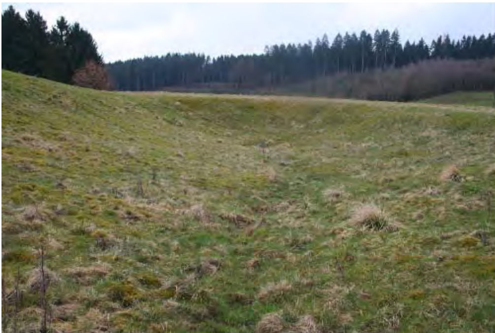
Bild 17: künstlich angelegtes Regenrückhaltebecken
