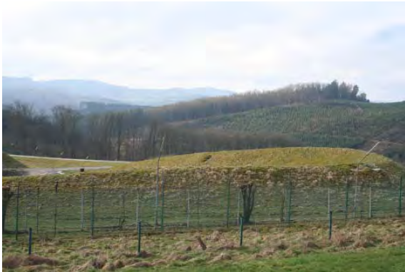
Bild 13: Beispiel einer Aufschüttung
