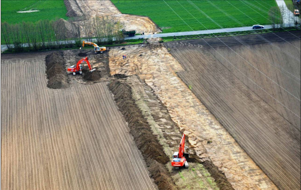
Abbildung 8: Abheben und Lagern des Mutterbodens (Oberboden)
