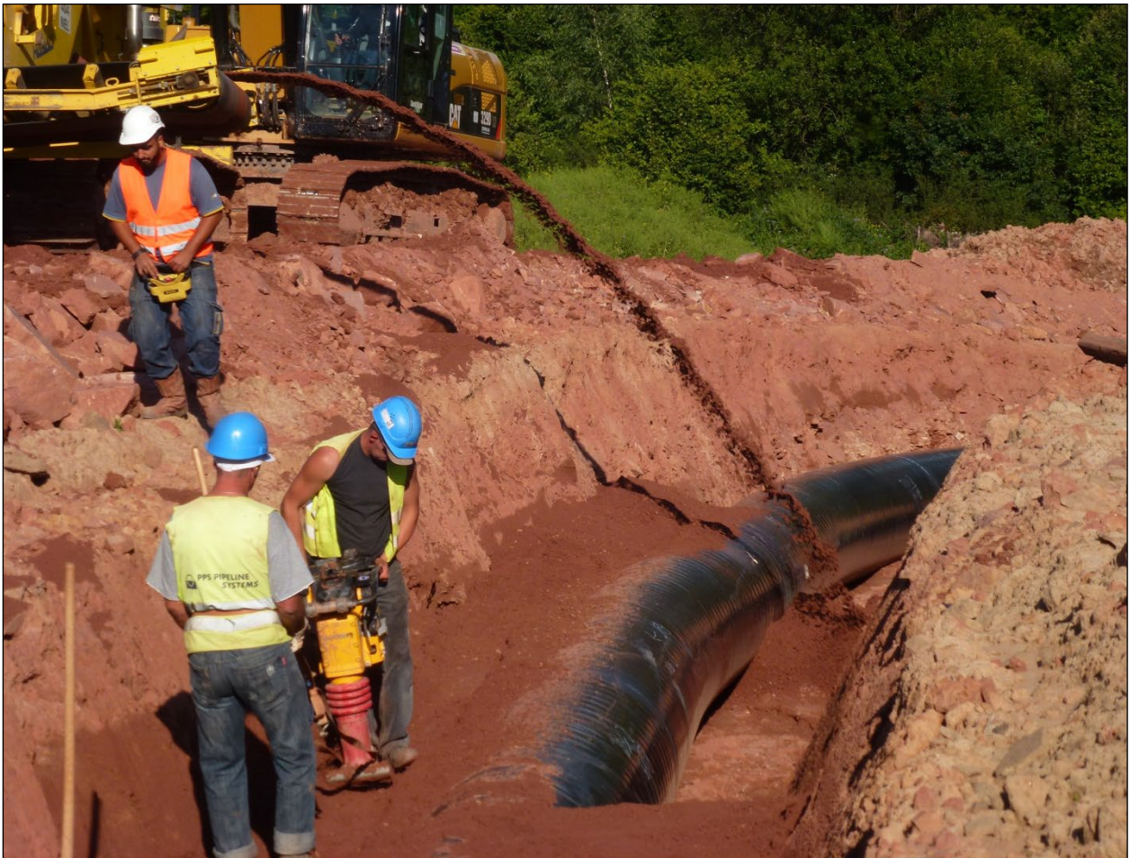
Abbildung 13: Verfüllen des Rohrgrabens
