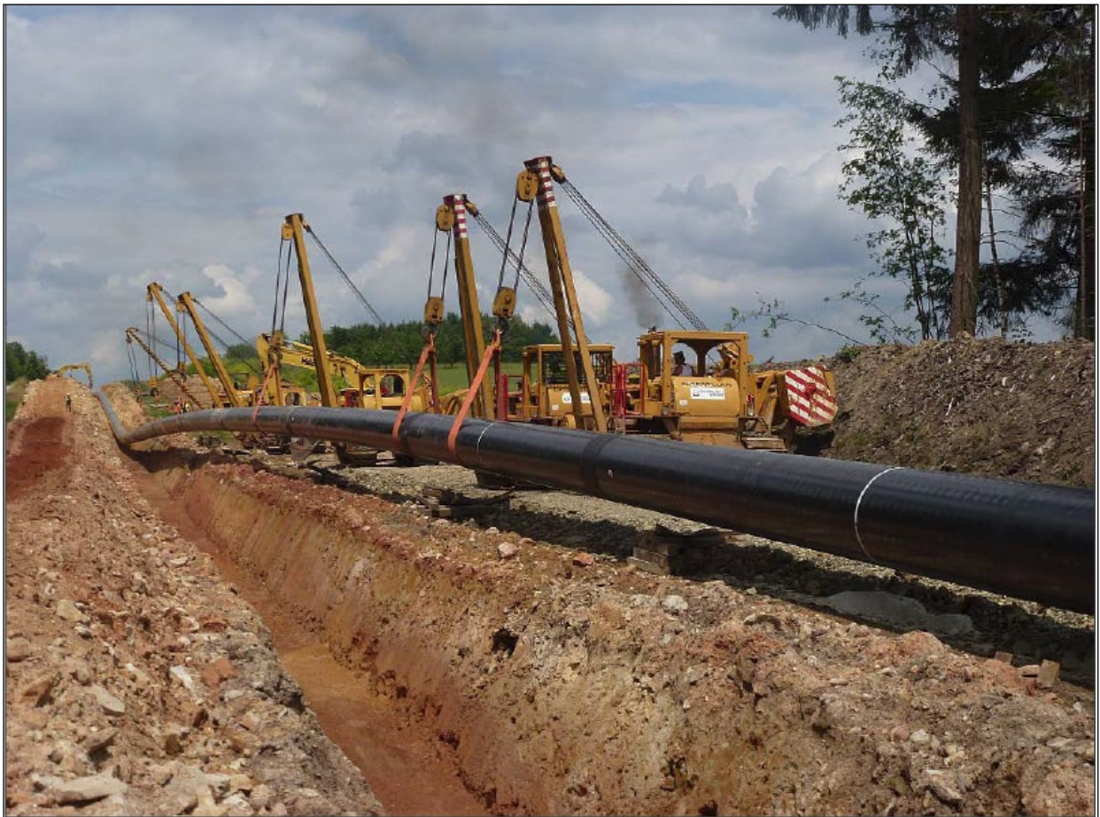
Abbildung 12: Absenken des Rohrstranges
