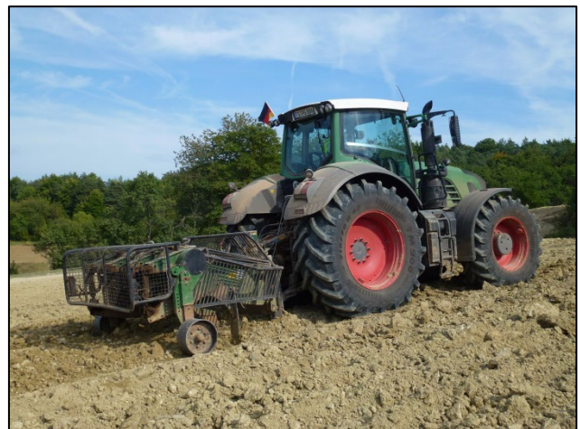
Abbildung 14: Rekultivierung des Arbeitsstreifens
