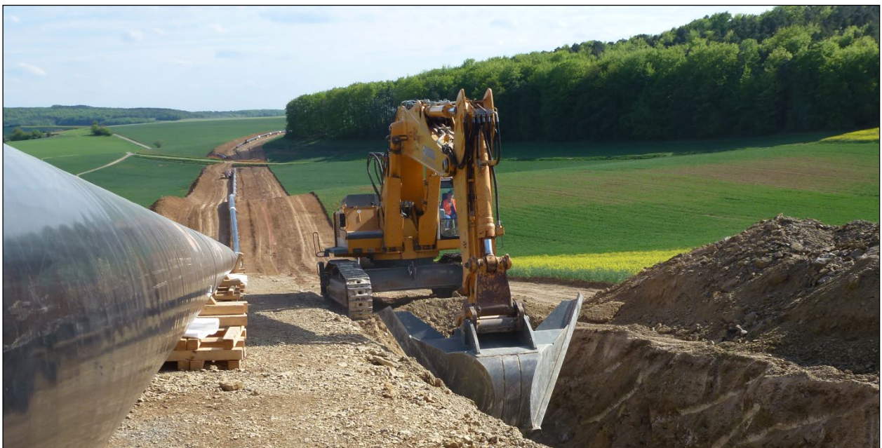
Abbildung 11: Aushub des Rohrgrabens
