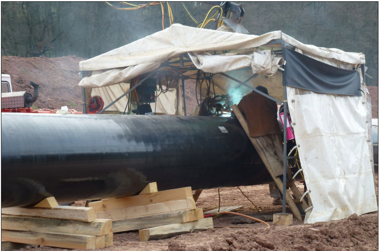
Abbildung 10: Verschweißen der Rohre zum Rohrstrang
